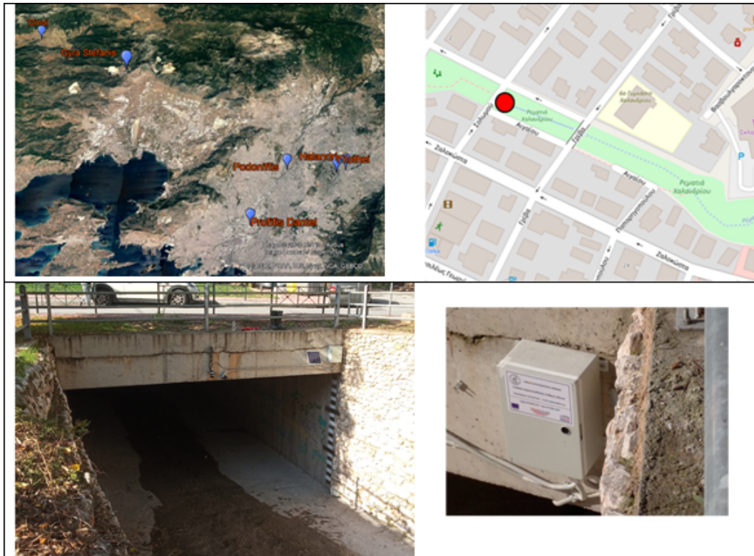
Εικόνα 39: Σταθμοί HYDRO-NET στο Λεκανοπέδιο Αττικής - Λεκάνη απορροής του Ποδονίφτη, ρέμα (υπολεκάνη) Χαλανδρίου: εγκατεστημένος πλήρης υδρο-τηλεμετρικός σταθμός ίδιας κατασκευής.
