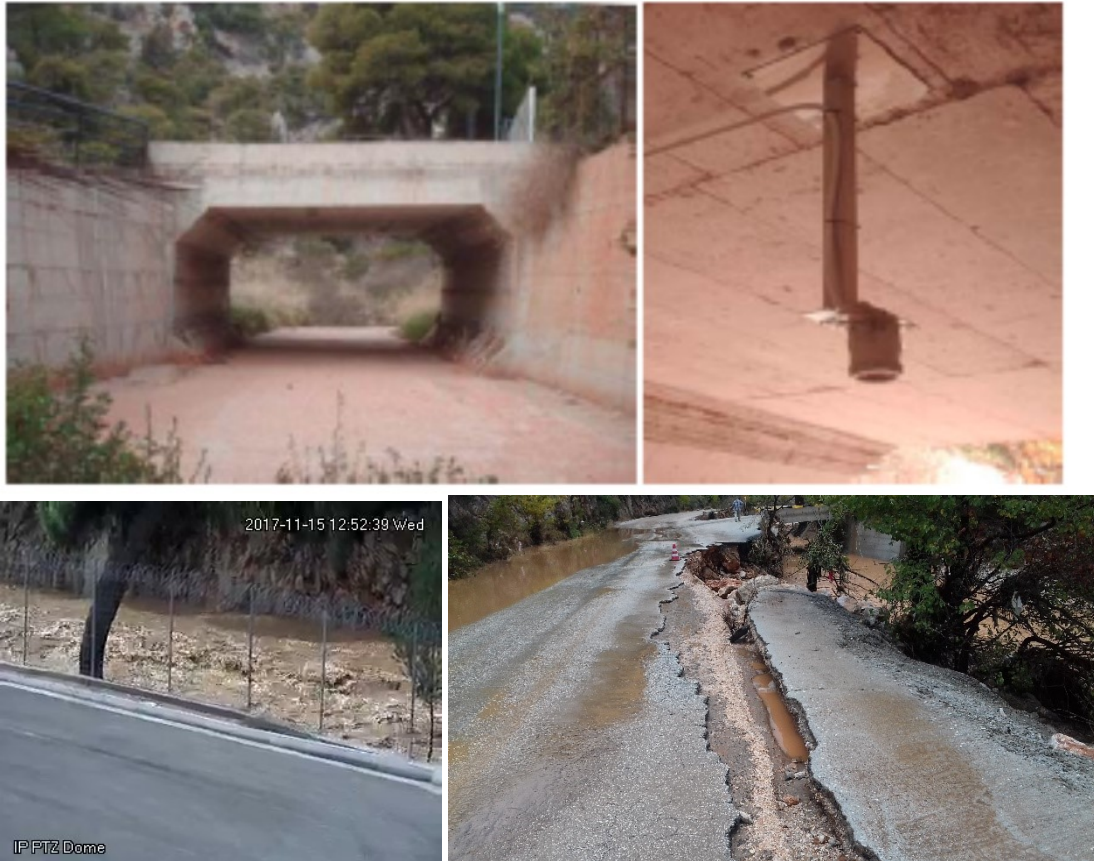
Εικόνα 16: Ο υδρομετρικός σταθμός στον Σαρανταπόταμο, θέση Γύρα Στεφάνης. Πάνω: Θέση και σταθμός (πριν την 15/11/2017), Κάτω: αριστερά η πλημμύρα, δεξιά η κοίτη αμέσως κατάντη του σταθμού στις 16/11/2017.
