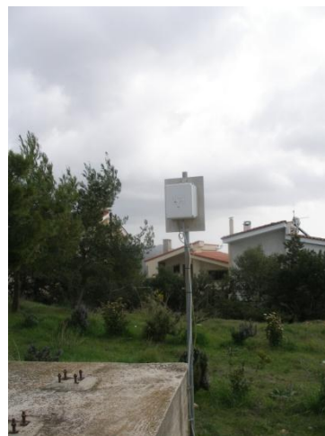
Εικόνα 3-6. (α) Γεωγραφική κατανομή των αισθητήρων του συστήματος ZEUS, (β) Η εξωτερική μονάδα ανίχνευσης των ηλεκτρικών εκκενώσεων.
