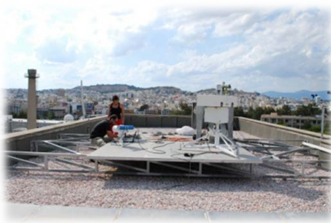
Ο Σταθμός Ατμοσφαιρικής Τηλεπισκόπησης (ΣΑΤ)
