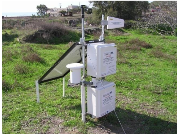
Εικόνα 4.1.11-1. Μαγνητομετρικός σταθμός στη Σαντορίνη.
