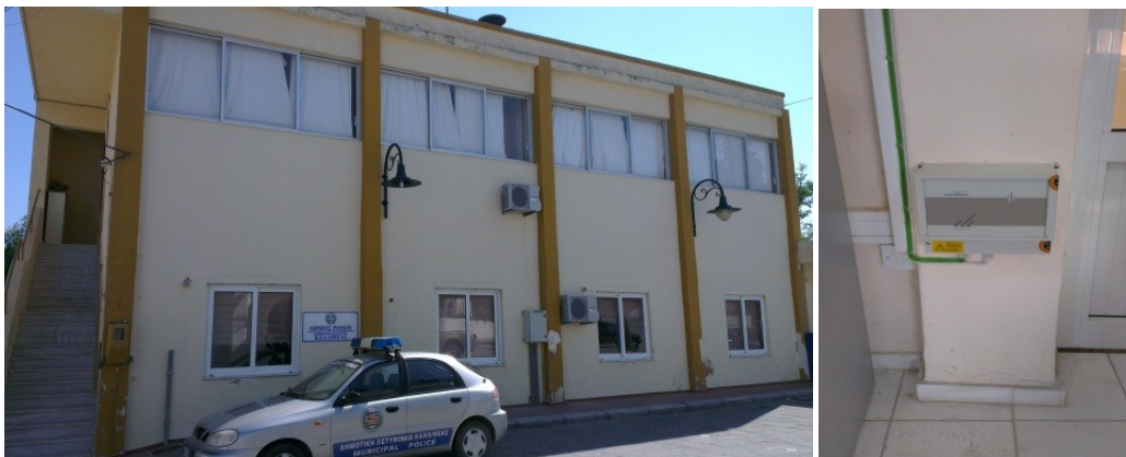
Εικόνα 4.1.10-1. Παράδειγμα συσκευής σεισμικής ειδοποίησης εγκατεστημένης στο εσωτερικό δημαρχιακού κτιρίου στη Ρόδο.
