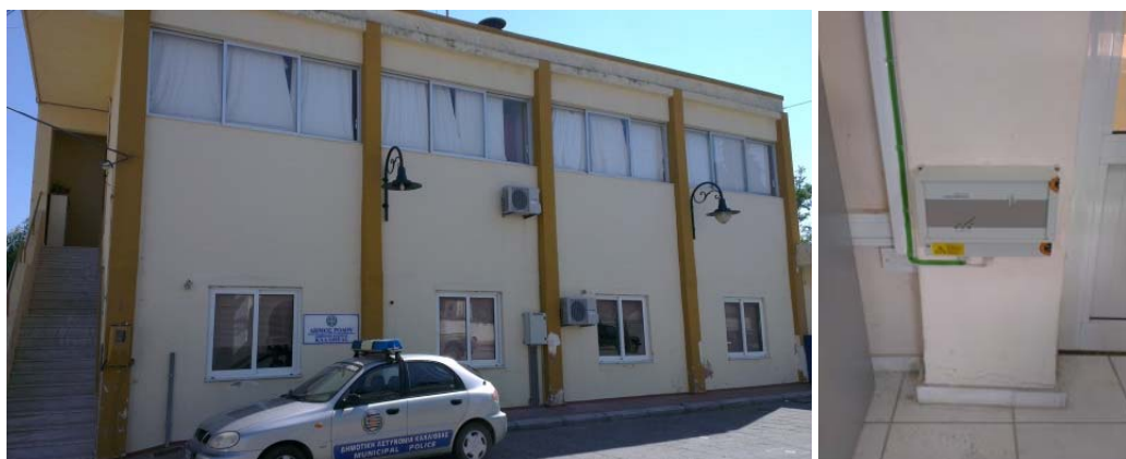
Εικόνα 3-22. Παράδειγμα συσκευής σεισμικής ειδοποίησης εγκατεστημένης στο εσωτερικό δημαρχιακού κτιρίου στη Ρόδο.
