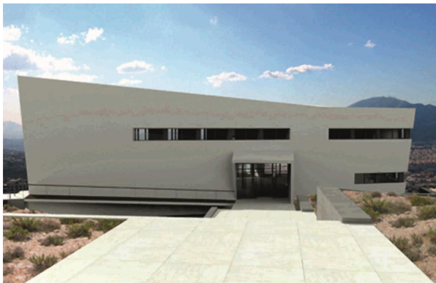
Εικόνα 17. Ολοκληρώθηκε το 2015 σε μεγάλο βαθμό η κατασκευή του φέροντα οργανισμού του νέου κτηρίου του Γ.Ι. στην Πεντέλη.
