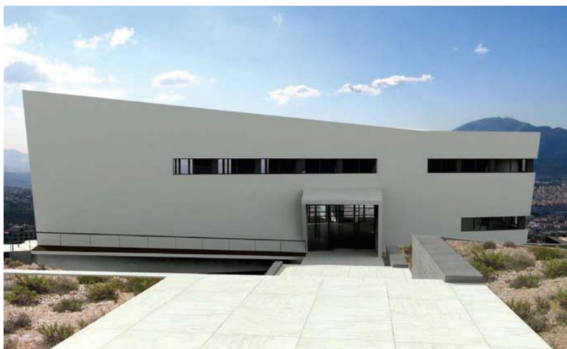
Εικόνα 4 . Εξωτερική άποψη του νέου κτηρίου του Γ.Ι.
