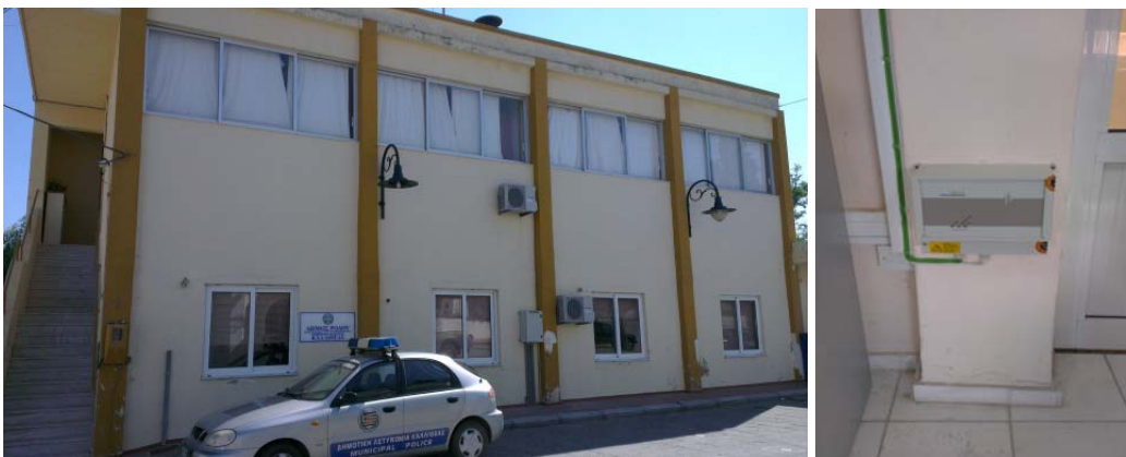
Εικόνα 16. Παράδειγμα συσκευής σεισμικής ειδοποίησης εγκατεστημένης στο εσωτερικό δημαρχιακού κτιρίου στη Ρόδο.
