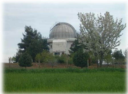
Το κτήριο του θόλου στο Αστεροσκοπείο Κρουονερίου που στεγάζει το τηλεσκόπιο με διάμετρο κατόπτρου 1.23 μ.
